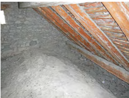
Combles de l'abside
