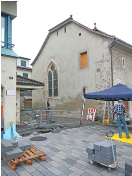
Nouveau dallage de la Pl. des Anciens Fossés
