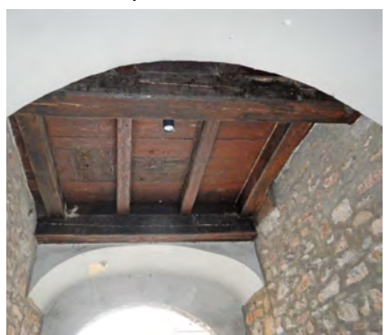
Vue sous le clocher
