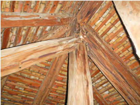
Charpente de la nef
