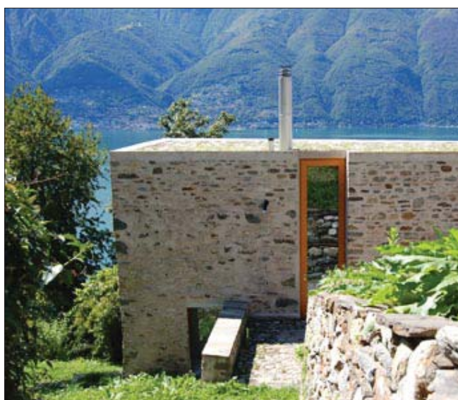
Maisons individuelles, Tessin (CH), architectes M. Wespi et J. De Meuron
