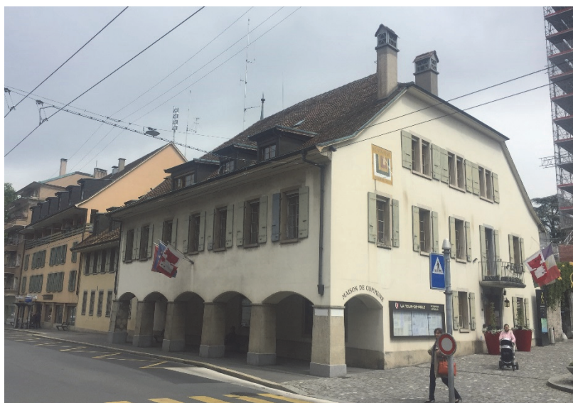
Vue de la Maison de Commune depuis la Gd-Rue – avant travaux
