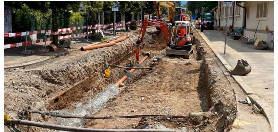
Travaux de mise en séparatif - Av. des Mousquetaires - juillet 2020
